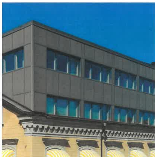
Installation i fastigheten Klockstapeln, Gävle
