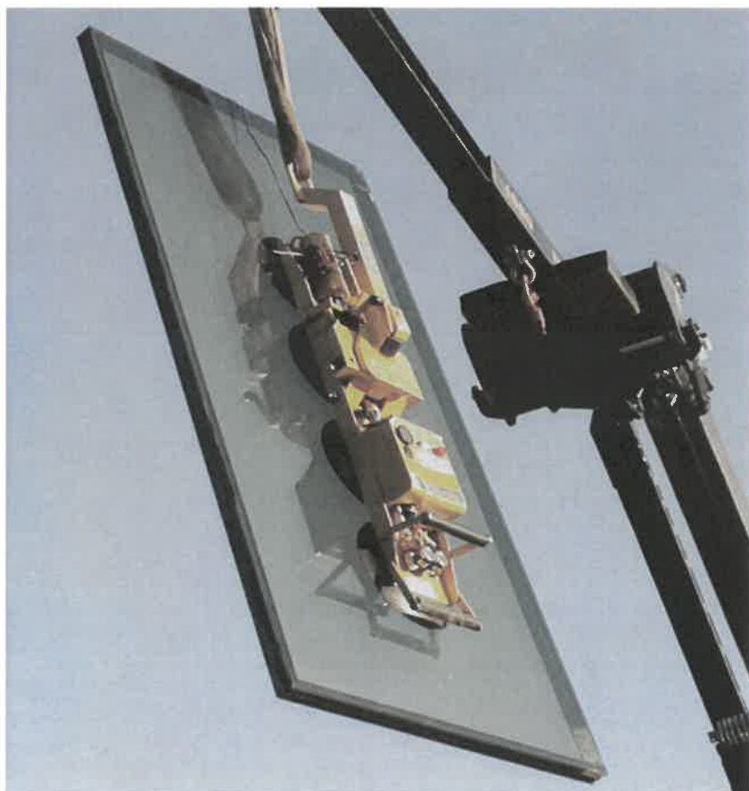
Kranlyft för inmontering av en glasenhet
