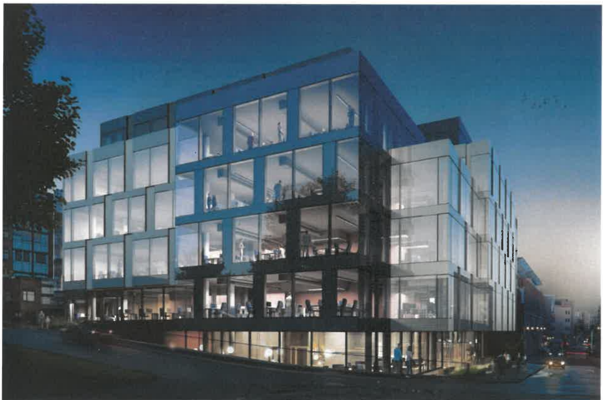
Gullhaugs Torg 5 i Oslo, Norge
