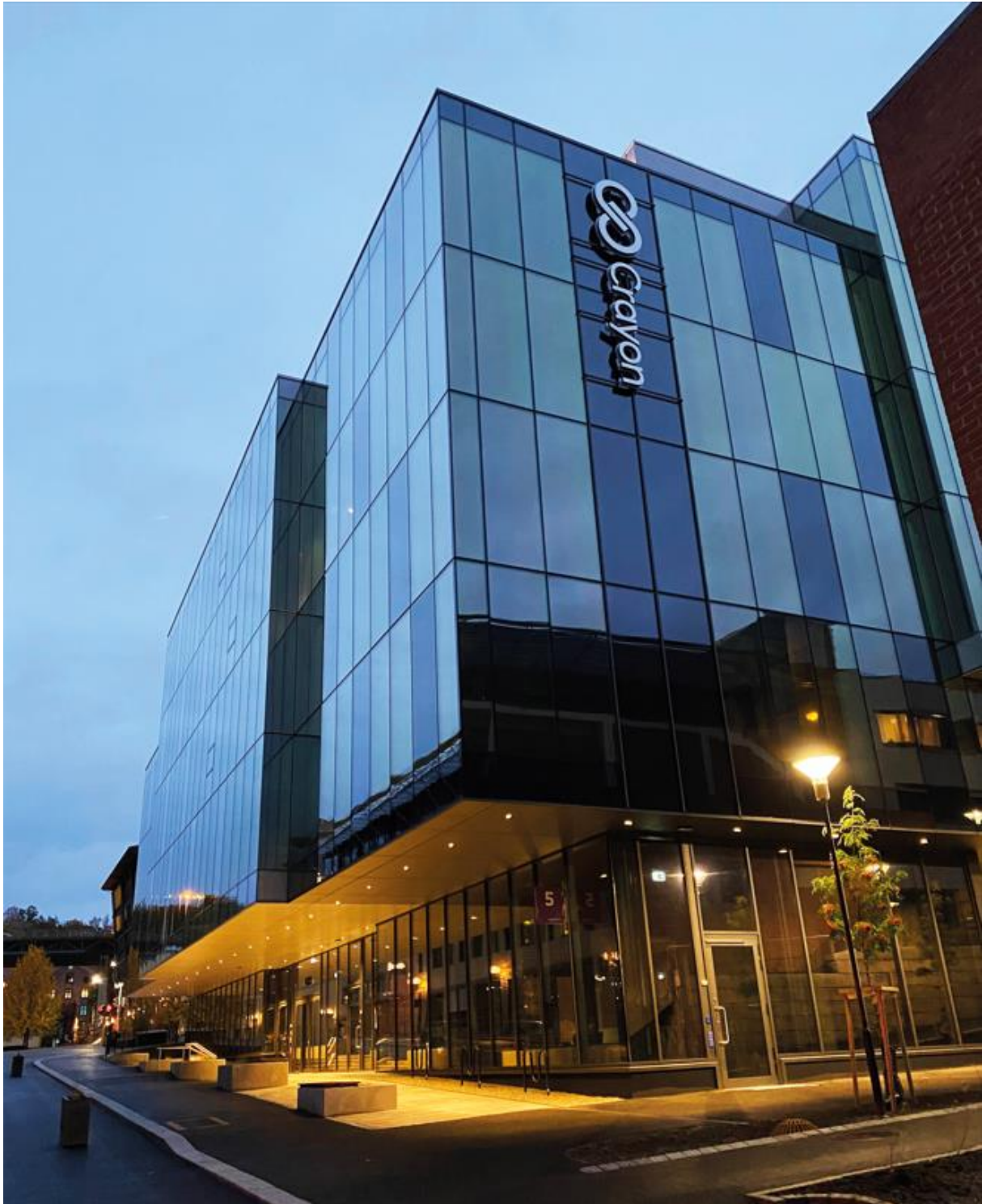
Gullhaug Torg 5, Oslo
