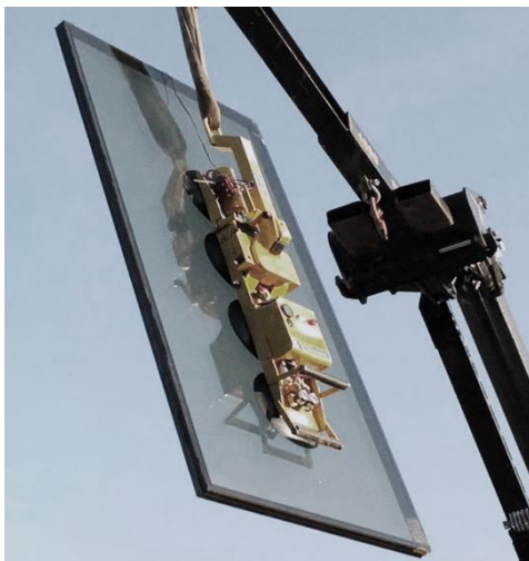
Kranlyft för inmontering av en glashet
