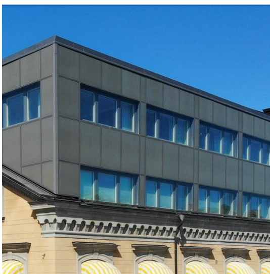
Installation i fastigheten Klockstapeln, Gävle
